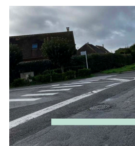
Création d'un passage piéton entre le lotissement de la Cour Fortin et le bassin.
