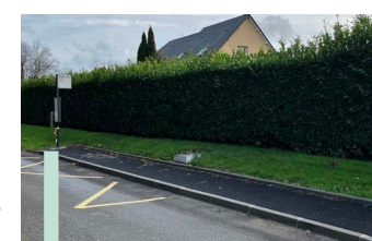
Création d'un arrêt de bus au Hameau d'Enfer.
